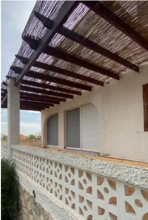
Foto 01: Cubierta 01 - Estado original. Vista interior
