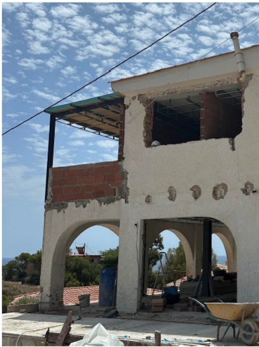
Foto 04: Cubierta 01 - Estado derribado.
