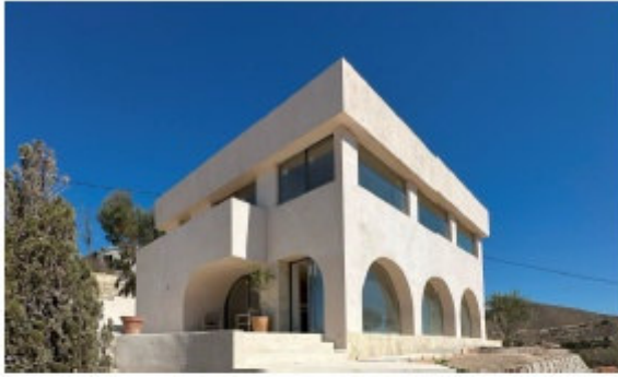
Foto 06: Cubierta 02 - Estado reformado. Vista sur
