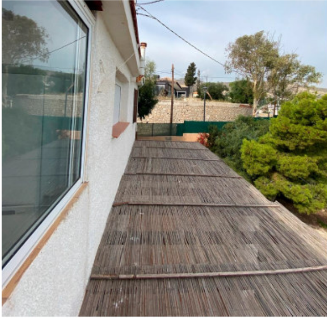
Foto 02: Cubierta 01 - Estado original. Vista superior
