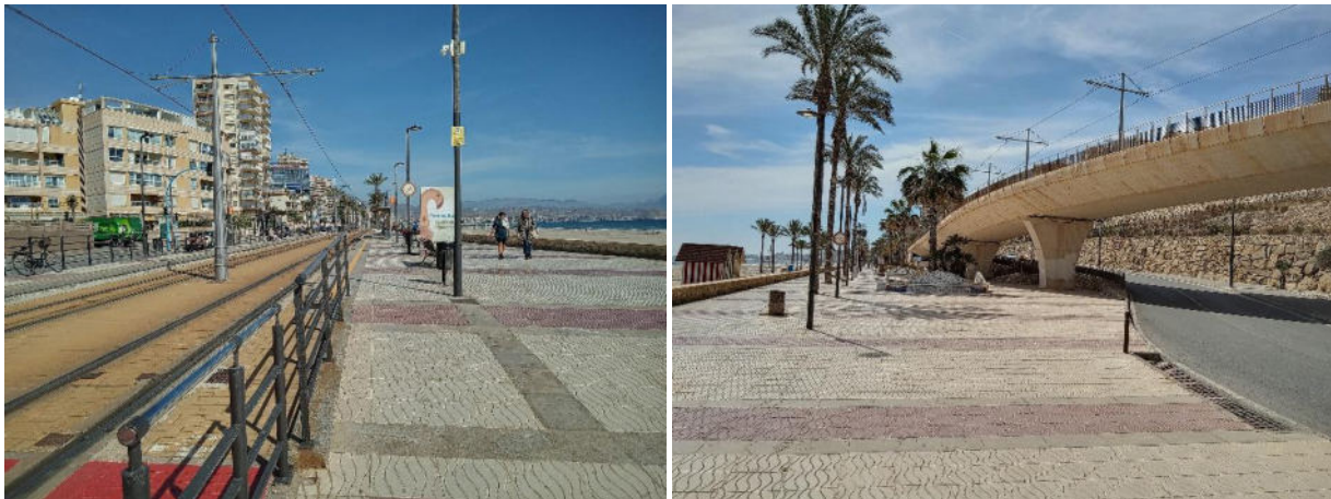
Imagen 16: Apeadero “Les Llances” y puente sobre la Avenida Jaime I.
