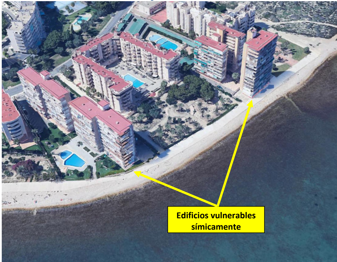
Imagen 45: Edificios vulnerables sísmicamente en el Rincón de la Zofra. Visor: Google Earth.
