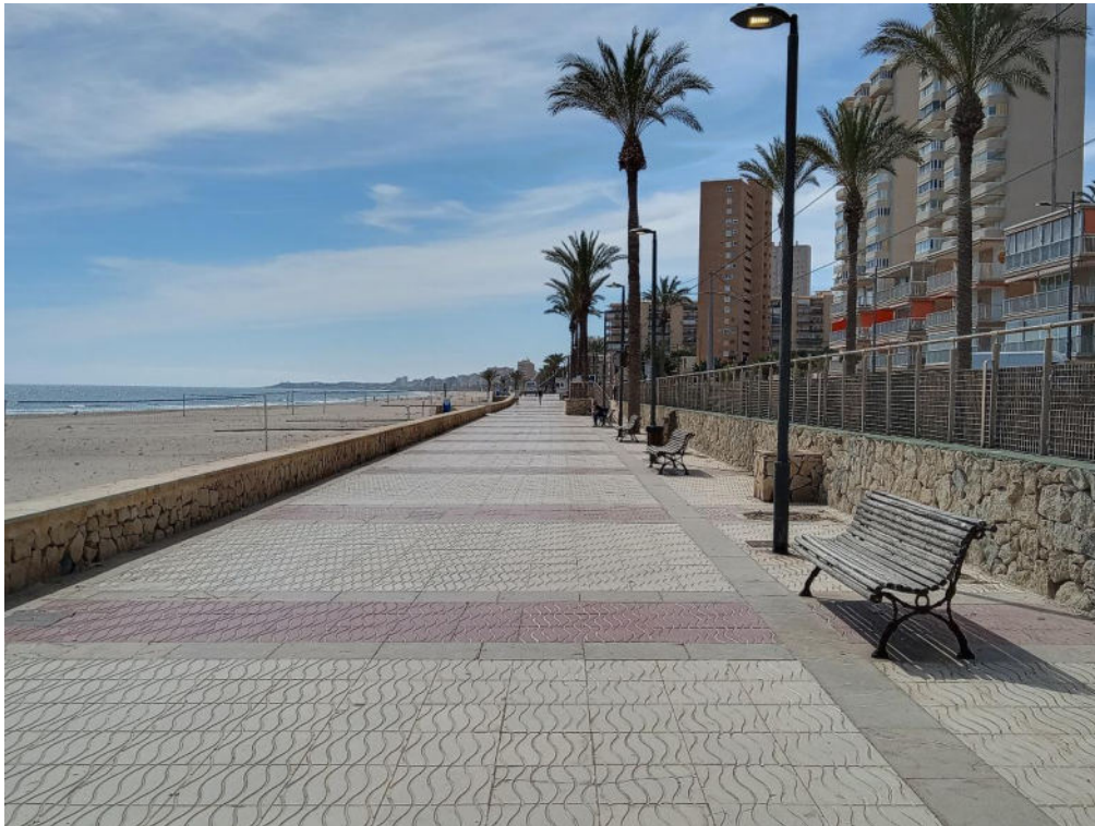
Imagen 03: Alturas del muro respecto del pavimento.
